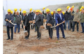
Den künftigen kleinen Hafen im Rücken, bewegen Ditmar Gurk, Christian Heinrich-Jaschinski, Manfred Kolba, Volker Mielchen und Gottfried Richter (v.l.) den ersten Boden für den Weg dorthin. Foto: Gabi Böttcher
